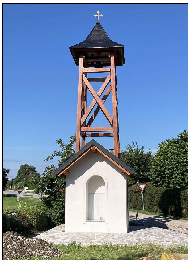
Der komplett neu errichtete Glockenstuhl
